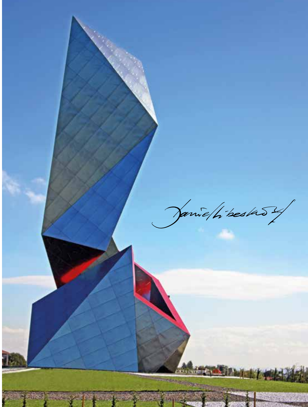
The Ceramic Crown _ Architettura realizzata a Casalgrande, Reggio Emilia, rivestita da 700 lastre di gres porcellanato.
