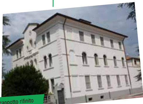
Isolamento termico a cappotto rifinito con Silancolor Tonachino - Condominio S.Francesco, Caltanissetta
