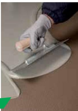
Mapelastic Turbo è facilmente lavorabile: riesce a mantenere la lavorabilità per oltre 45 minuti agevolando le attività di posa dell'applicatore.
