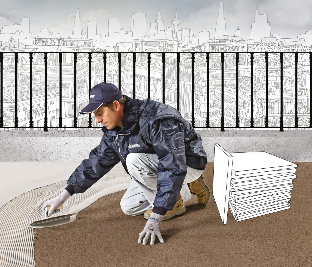
**Mapelastic Turbo** è l'impermeabilizzazione elastica per balconi e terrazzi. Rapida asciugatura anche a basse temperature e con sottofondi non perfettamente asciutti, **superando i limiti della stagionalità.**
