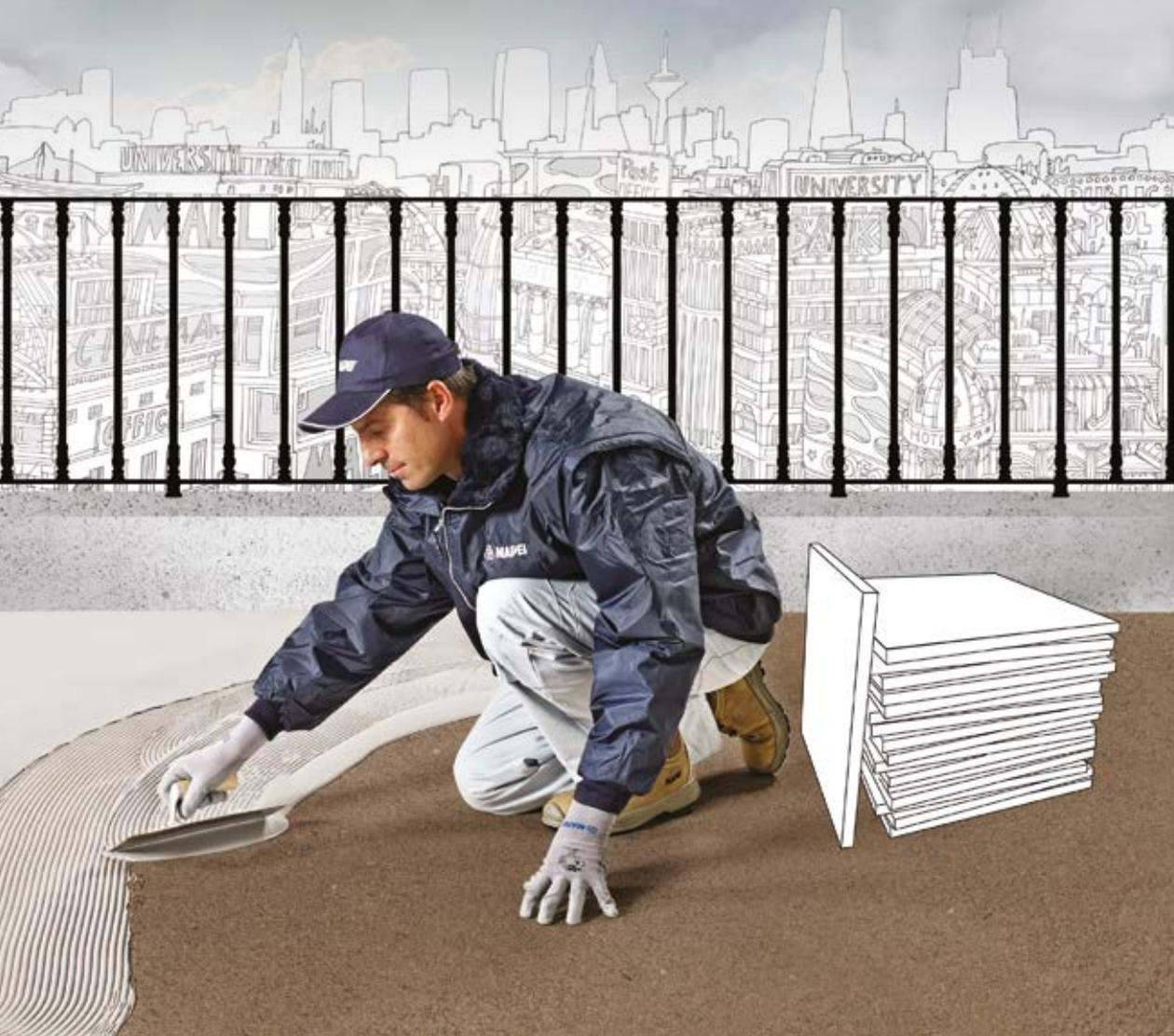
**Mapelastic Turbo** è l'impermeabilizzazione elastica per balconi e terrazzi. Rapida asciugatura anche a basse temperature e con sottofondi non perfettamente asciutti, **superando i limiti della stagionalità.**
